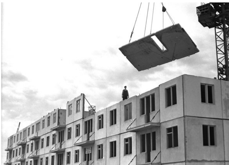
Строительство первого крупнопанельного дома. 1962. ЦГА КФФД КР
